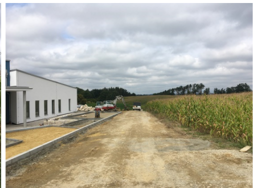
Kindertagesstätte, neue Erschließung, Landwirtschaftliche Nutzfläche Blickrichtung Süden nach Norden, oberer Bereich
