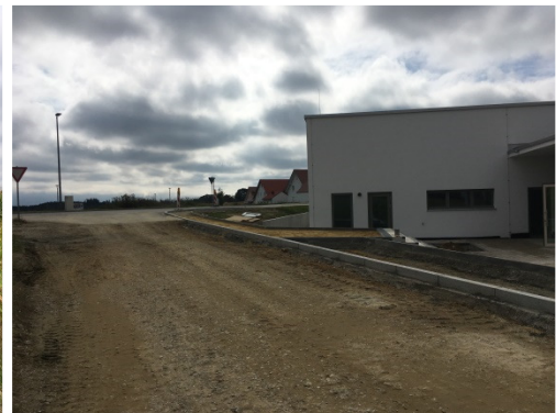
Friedrichstraße im Süden, neue Erschließung, Kindertagesstätte Blickrichtung Norden nach Süden
