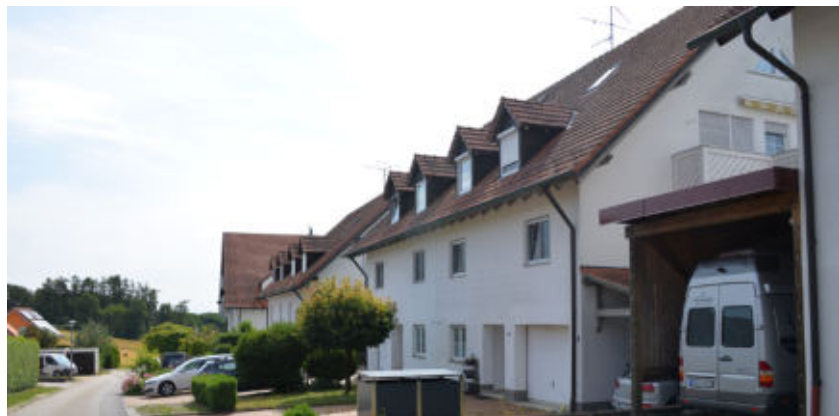
Mehrfamilienhaus in der Weinbergstraße
