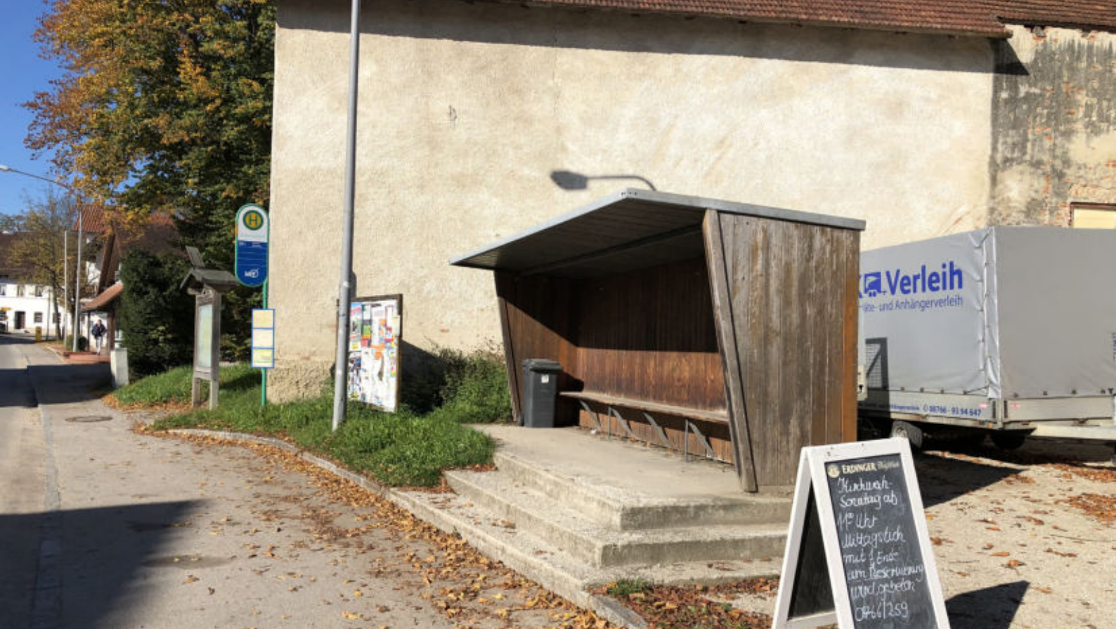
Nicht barrierefrei gestaltete Bushaltestelle
