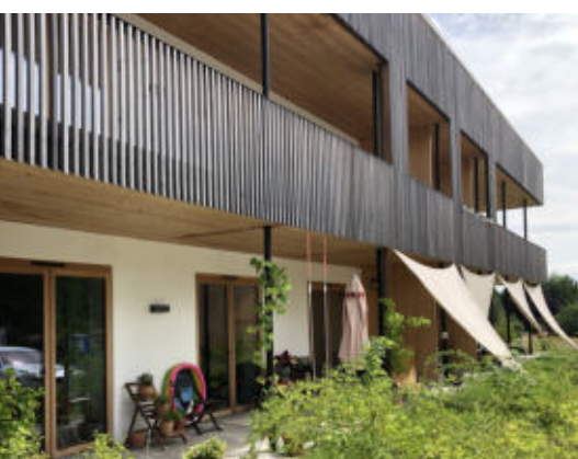
Marzling - privates Bauvorhaben
