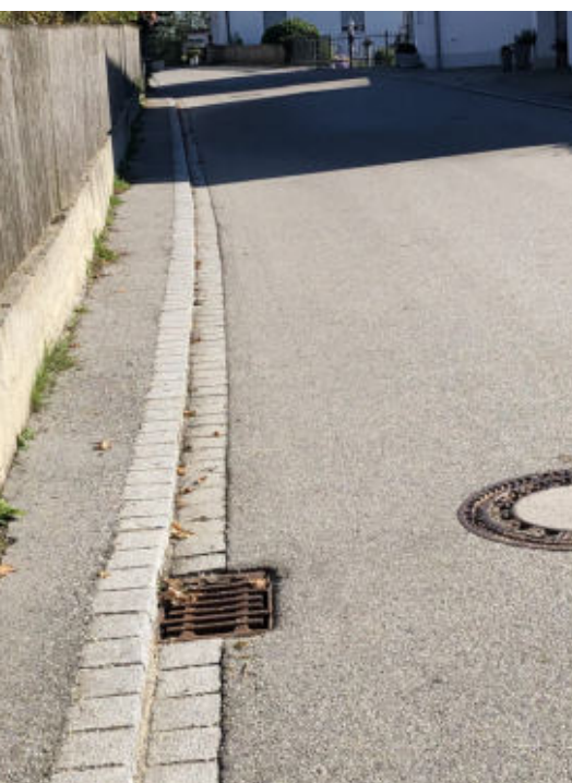
Gehstreifen entlang der Hauptstraße
