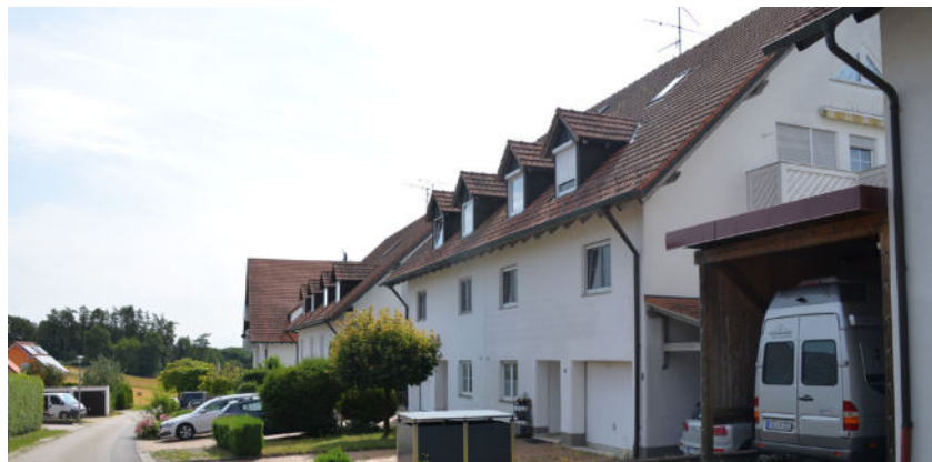
Mehrfamilienhaus in der Weinbergstraße
