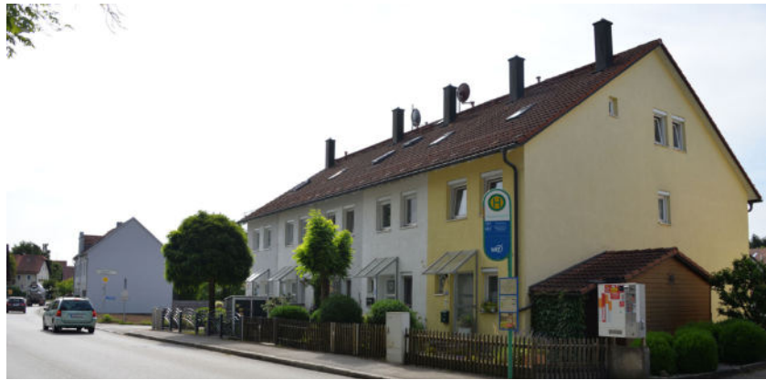
Reihenhaus an der Hauptstraße
