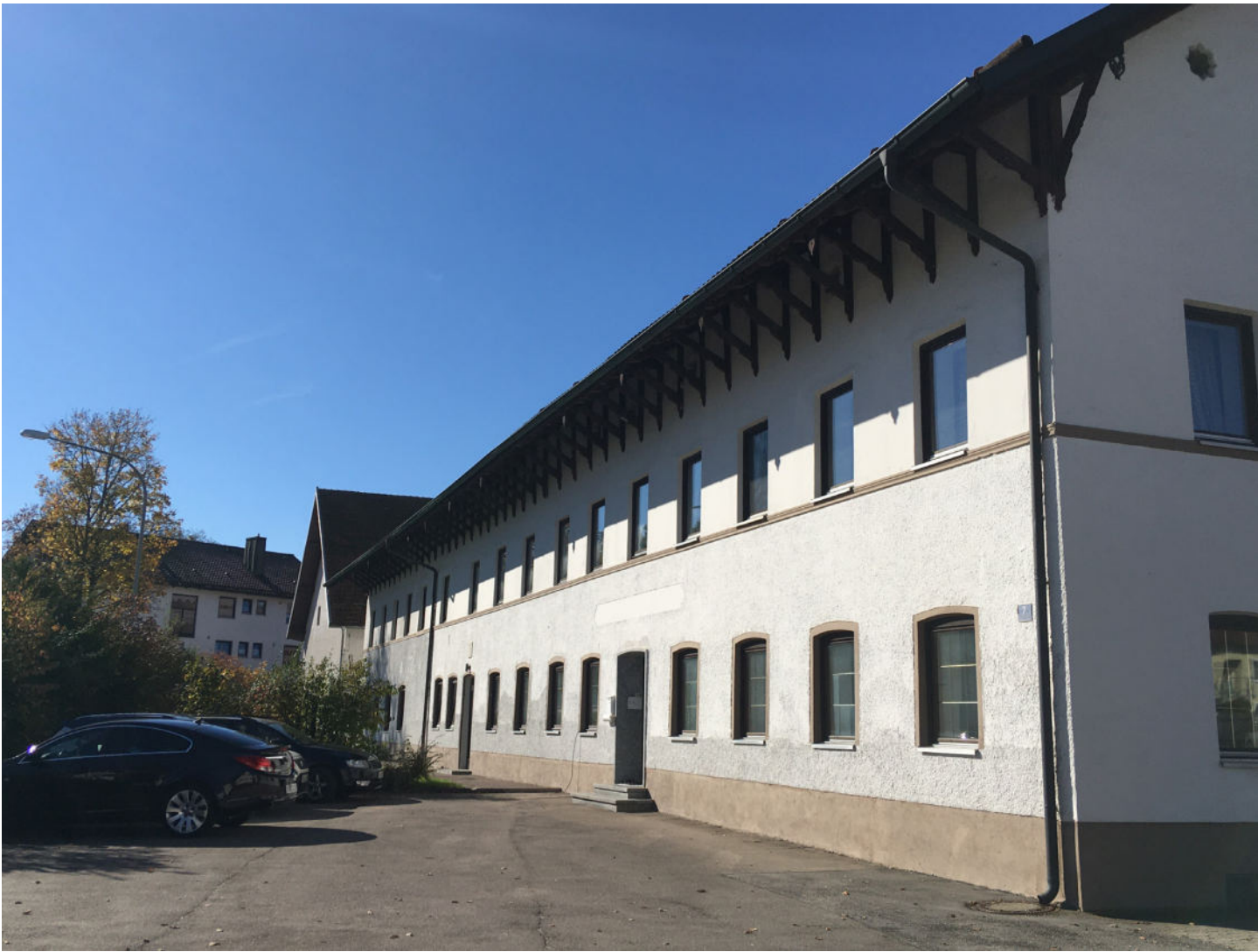
ehemaliges Gasthaus Kirchhamme: regelmäßige Anordnung der Fenster
