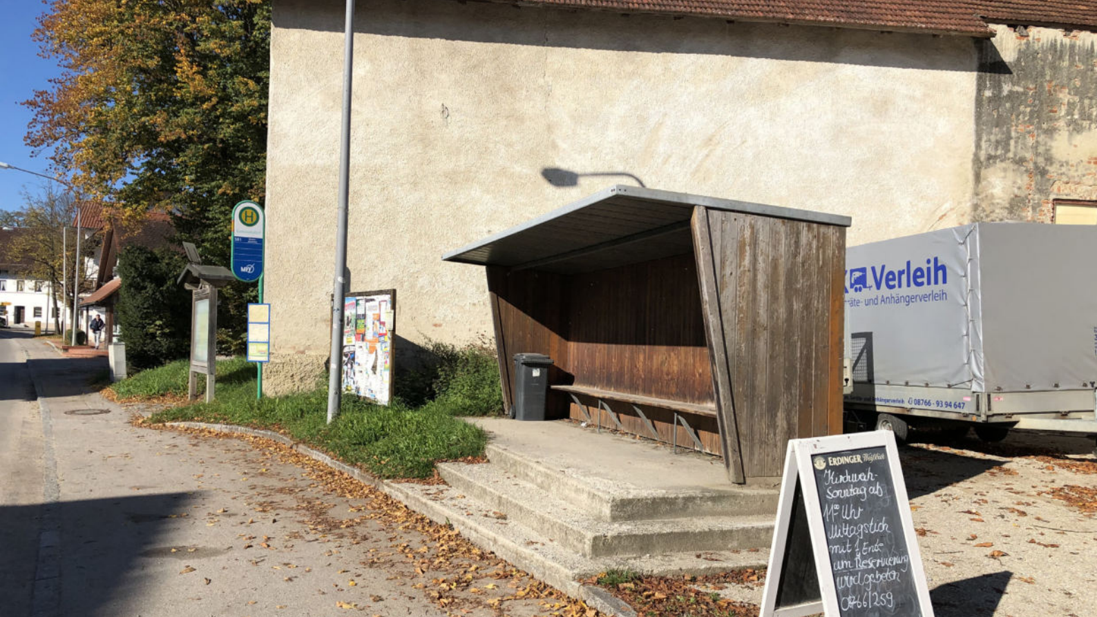
Nicht barrierefrei gestaltete Bushaltestelle
