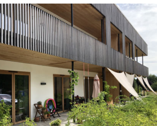
Marzling - privates Bauvorhaben
