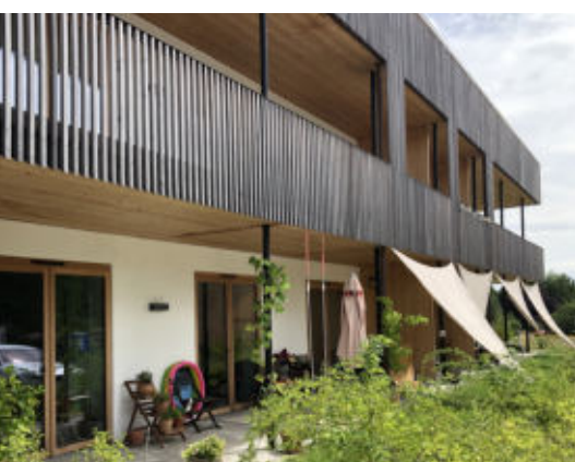
Marzling - privates Bauvorhaben
