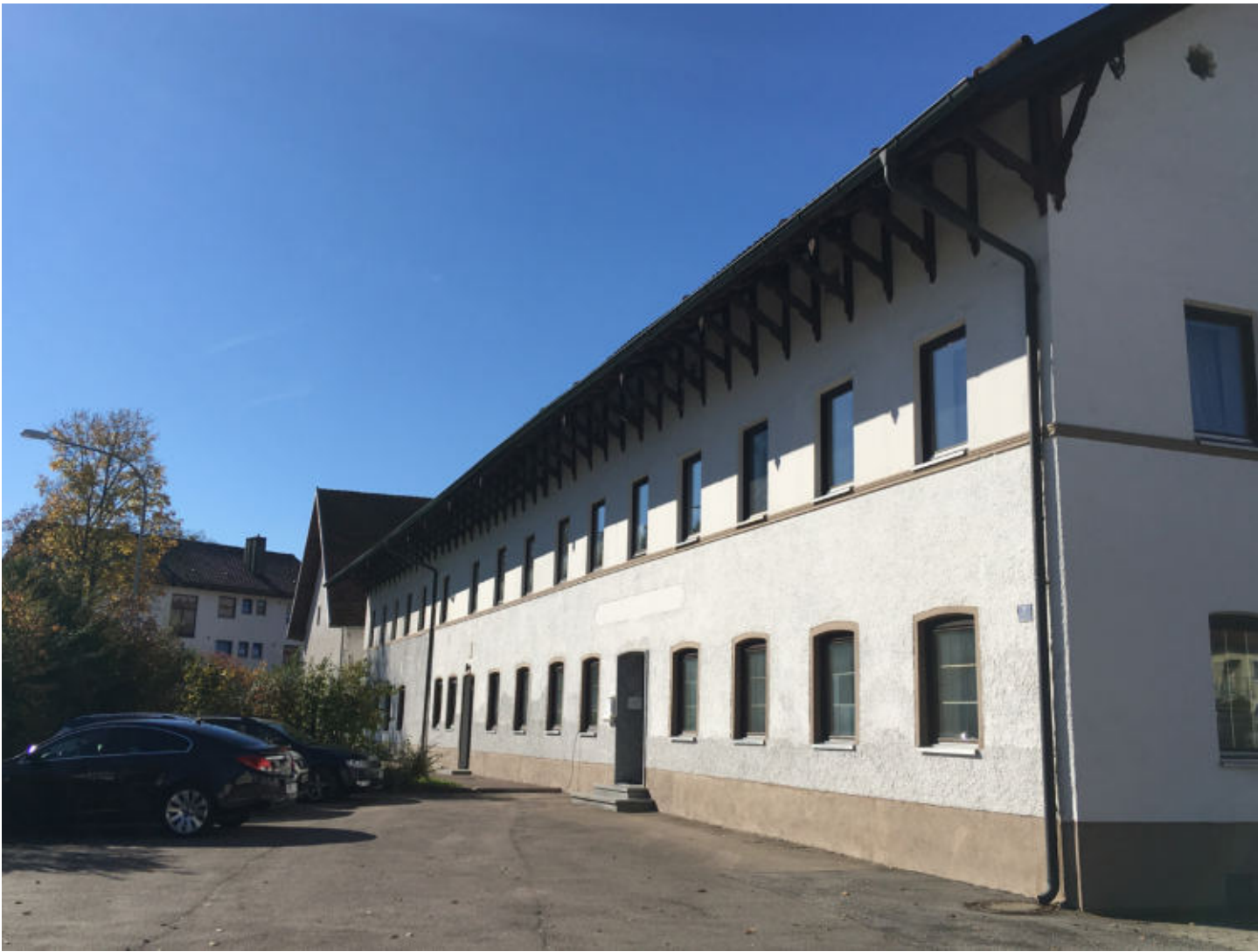
ehemaliges Gasthaus Kirchhamme: regelmäßige Anordnung der Fenster
