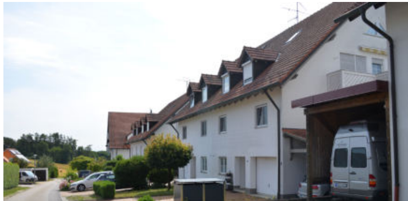
Mehrfamilienhaus in der Weinbergstraße
