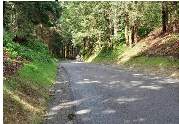
Straßenverbreiterung / Gandorfer Berg
