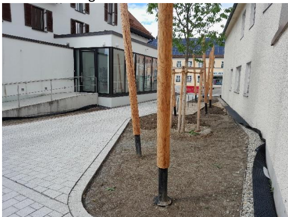
Hopfenstangen im östlichen Eingangsbereich Foto: Georg Krojer
