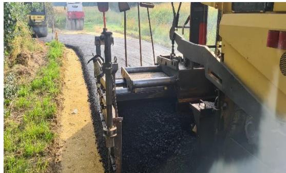
Asphaltarbeiten am Wertstoffhof
