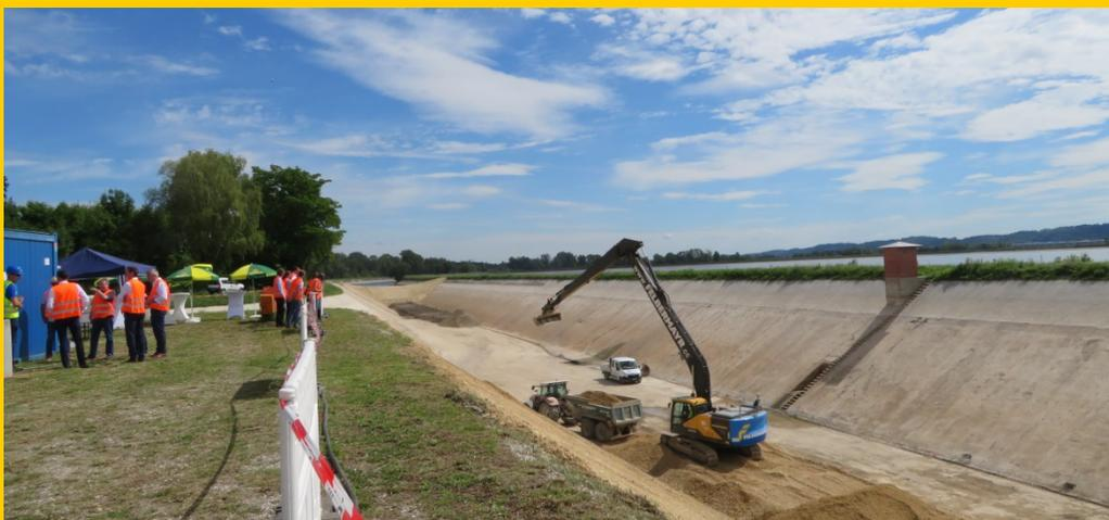
Die seit 1907 bestehenden Anlagen der SWM in der Spörerau werden derzeit saniert und sollen Anfang 2021 wieder voll leistungsfähig sein. Dazu wurde auch der Speichersee um 2 m gesenkt (= 2 Mio. Kubikmeter Wasser) und der Kanal teilweise trockengelegt. Bei Volllast werden hier bestenfalls 30 MW/h erzeugt, aufgrund der reduzierten Wassermenge läuft nur eine der drei Kaplan-turbinen und produziert etwa ein Drittel der üblichen Strommenge.
