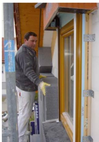
*Dieses Fenster wurde mit Außenwinkeln angebracht.*
