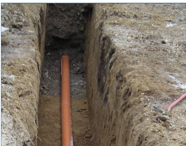
Abb. 6: Wenn eine Abwasserleitung erneuert werden muss, ist es sinnvoll, sie mit wenigen Bögen zu verlegen. So kann sie in Zukunft leichter geprüft werden.
