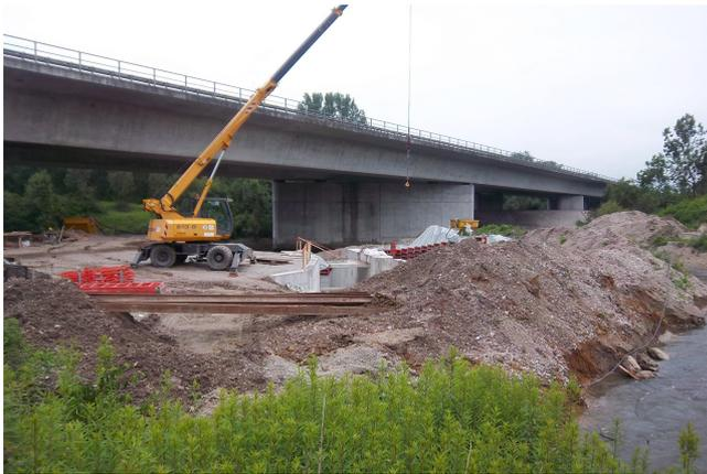
links: Die Sempt wurde umgeleitet (vorne rechts im Bild), um das Fundament im Trockenen errichten zu können.
