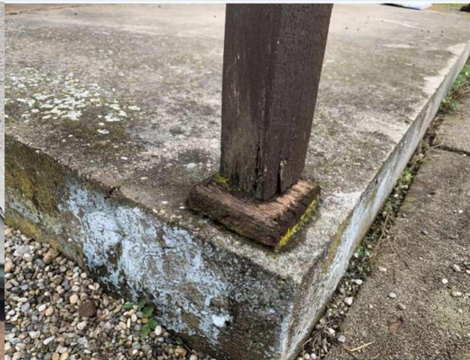
Abbildung 1: Fäulnisschäden am Stützenfuß
