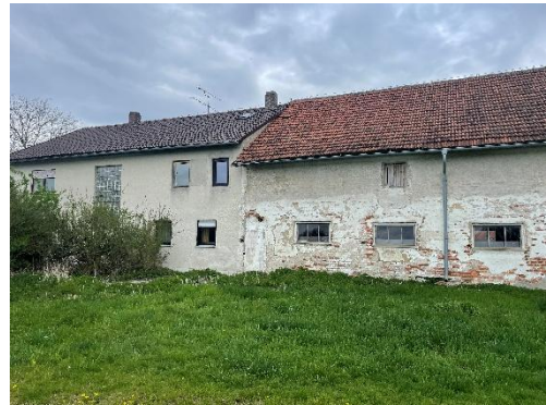
Blick von Nordwesten auf bestehende Gebäudestrukturen (hofabgewandte Seite) der Hofstelle.
