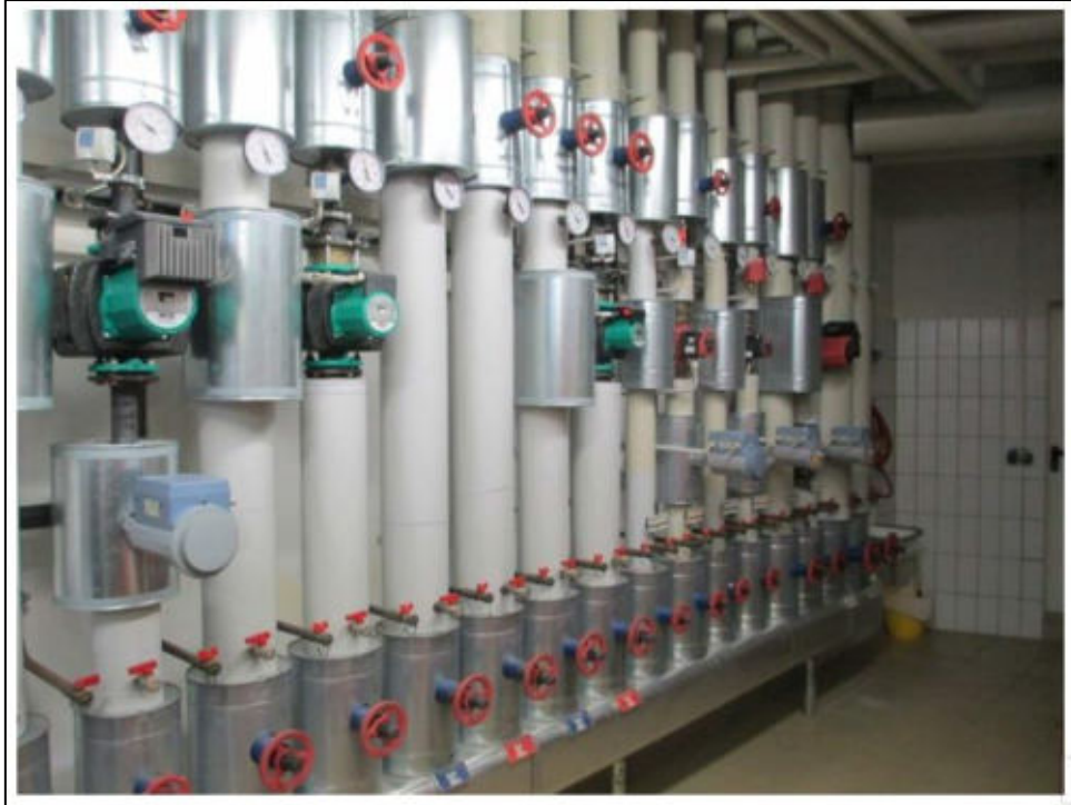
Abbildung 78: Heizungsverteiler
